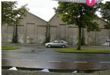
Klein stukje origineel industrieel verleden: muur van Bergoss.
